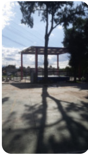
Fotografías 5, 6 y 7. Techumbre para captar agua de lluvia, y donde se ha instalado el ring de boxeo amateur
