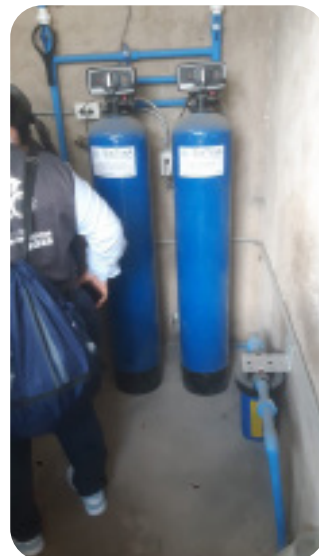
Fotografías 9, 10, 11 y 12. Bombas y purificadores para obtener el agua pura del agua pluvial cosechada, y cisterna
